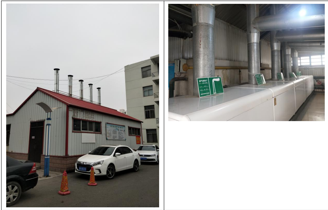
图 3-1 锅炉烟筒现场照片
